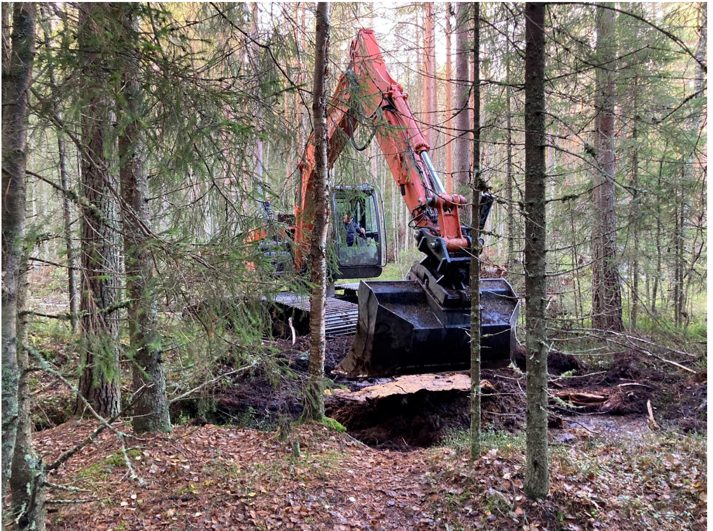
Kuva 6. Suon ojien patoamista Laajavuoressa.
